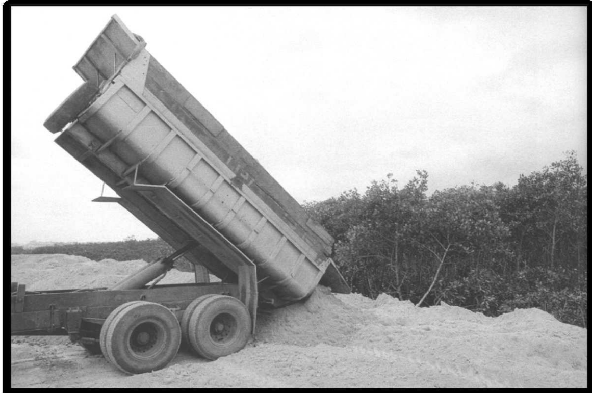
Figura 80 - Aterro em áreas de manguezais
