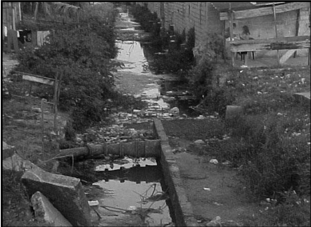
Figura 84 - Área de manguezal invadida e construção com lançamento de efluentes sanitários in natura em canal
